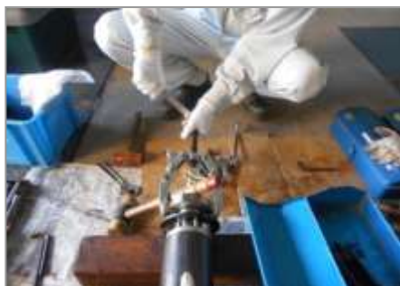
【水再生センターでの維持管理講習】
