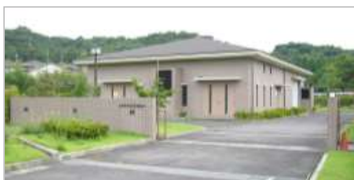
【大石中継ポンプ場】
