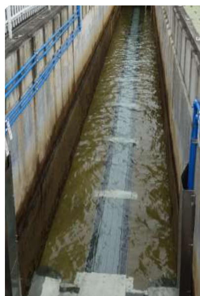
【消毒槽への熱回収管敷設状況】
