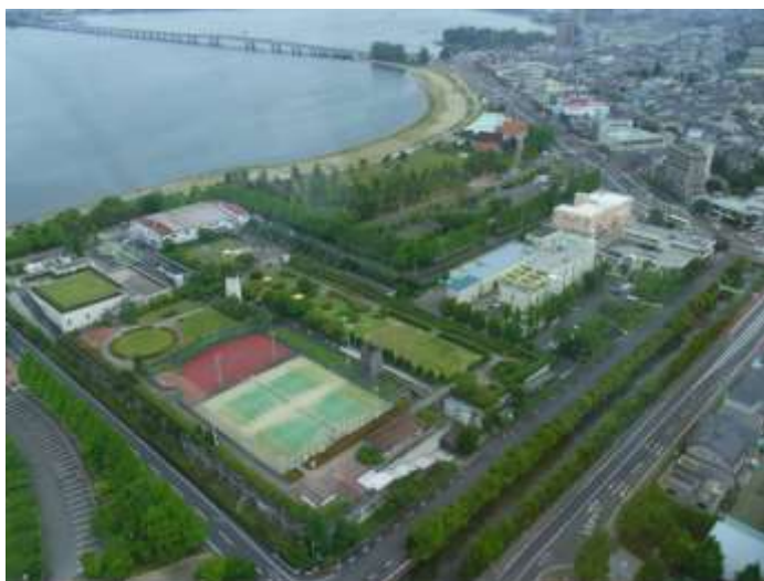
【大津終末処理場（水再生センター）航空写真】
