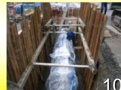
水道管の布設工事
