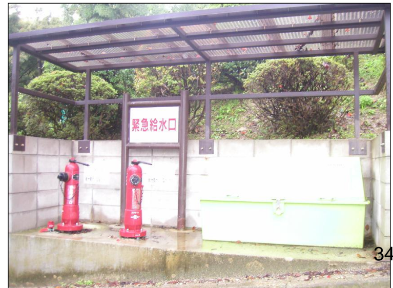
(非常用給水栓)
