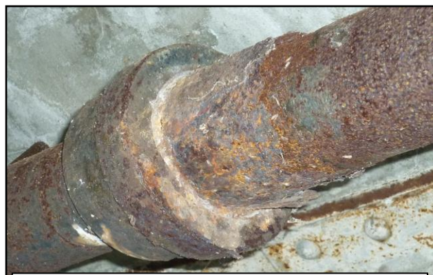
インロウ(鉛)継手部状況
