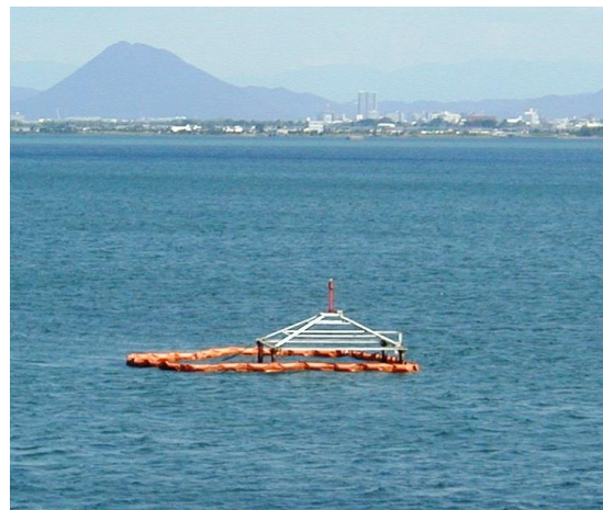
柳が崎浄水場の取水口
