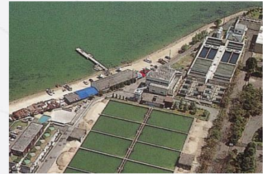
柳が崎浄水場
