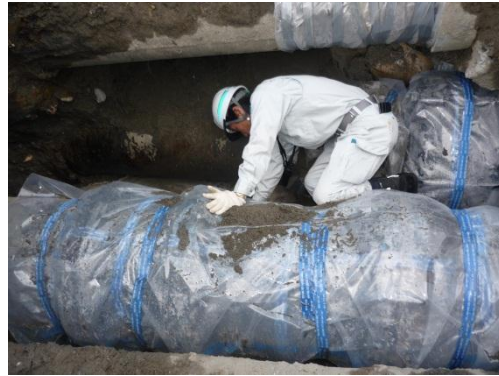
御陵町水道管の修繕状況
