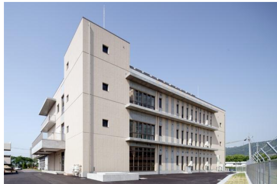
浄水管理センター外観
