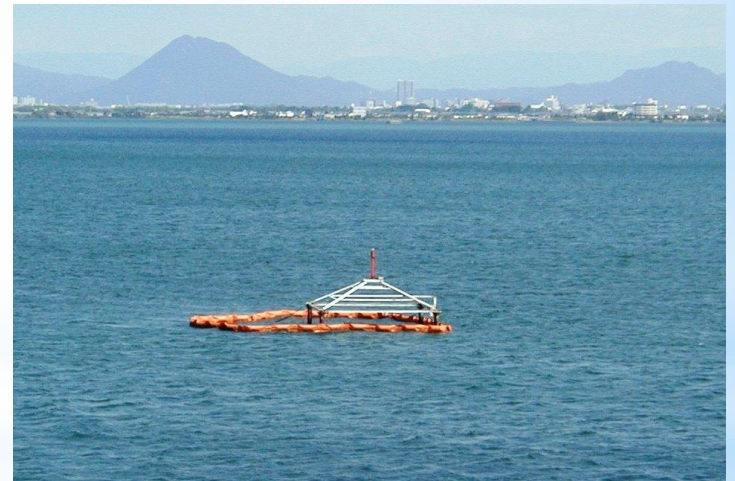
柳が崎浄水場の取水口
