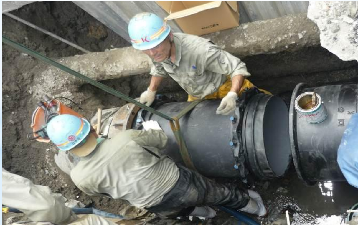
修繕工事の施工状況
