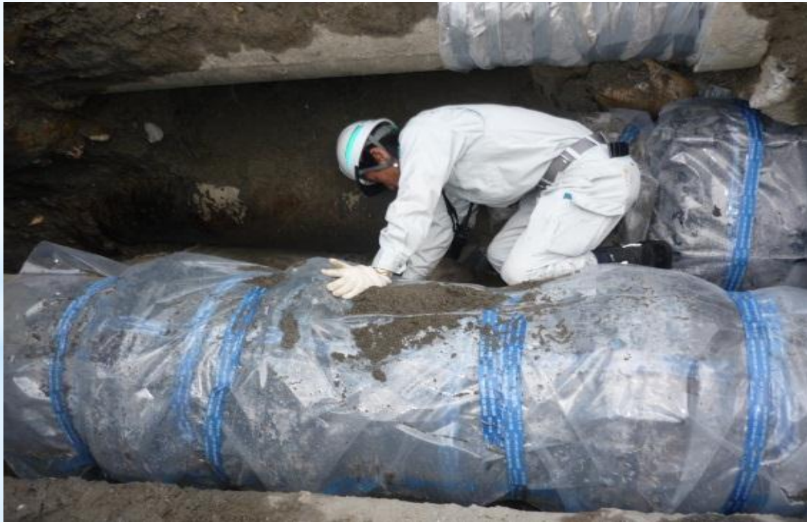
修繕工事の完了確認状況
