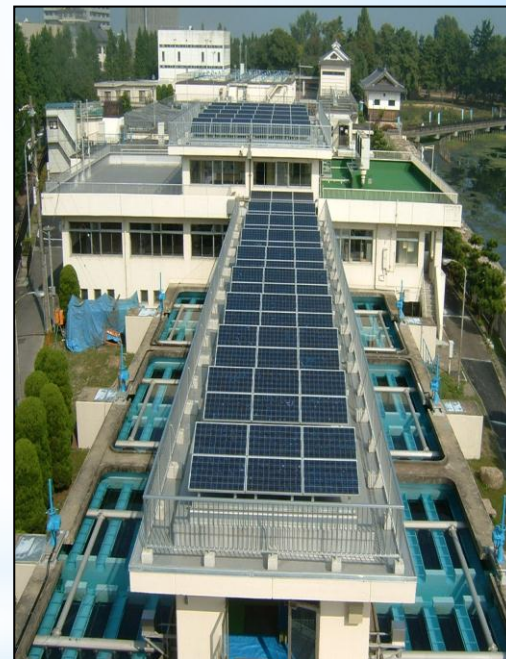
膳所浄水場の太陽光発電システム
