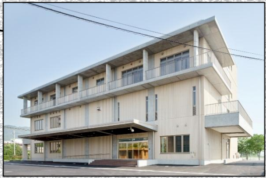
浄水管理センター(柳が崎浄水場内に建設)
