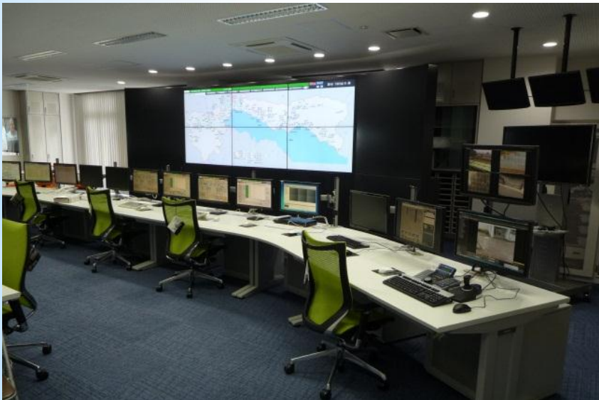
浄水管理センター中央監視室
