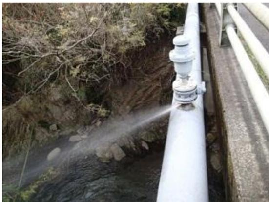
水管橋の漏水状況
