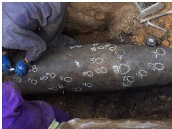
管外面の腐食が老朽化している水道管
