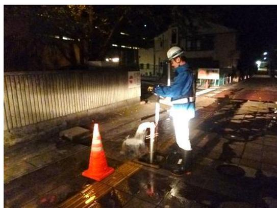
水道管の洗浄作業（夜間作業）
