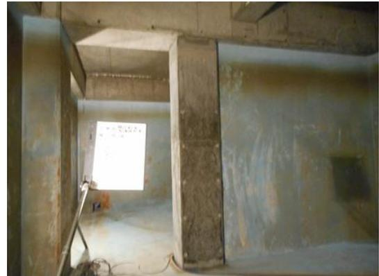
耐震補強工事（支柱の増設）施工後
