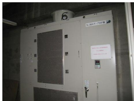
インバーター※<sup>3</sup>送水設備（真野浄水場）
