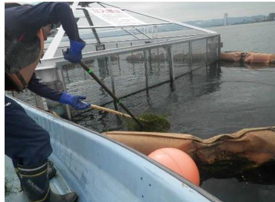
取水口に繁茂した水草の除去作業状況
