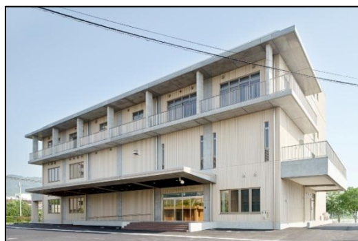
浄水管理センター
