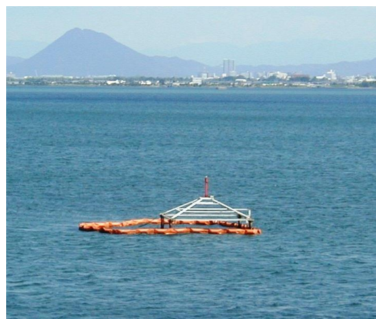
柳が崎浄水場の取水口
