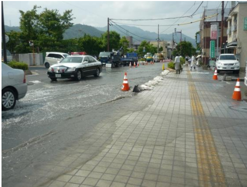
平成26年6月御陵町水道管漏水事故の状況
