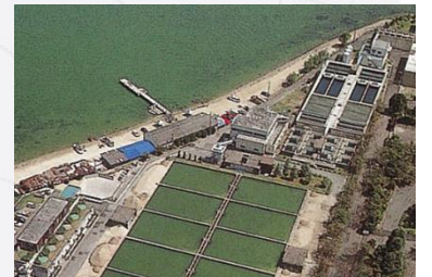
柳が崎浄水場
