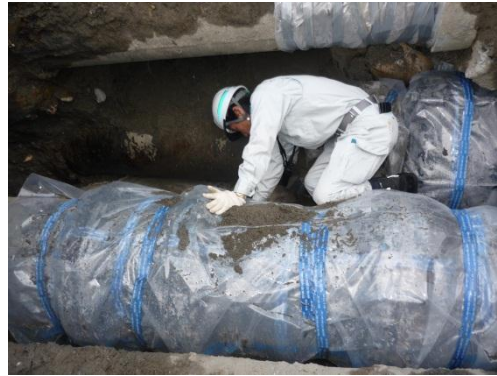
御陵町水道管の修繕状況
