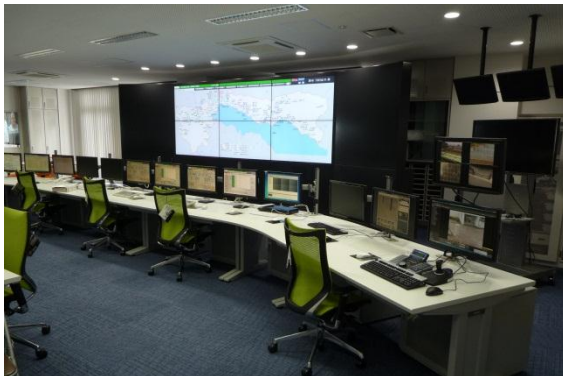
浄水管理センター中央監視室
