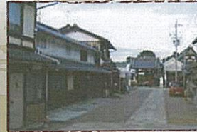
⑬伝統的木造建築による町並み（妙盛寺周辺）
