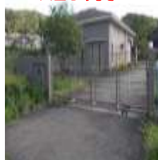
大石中継ポンプ場 H28 完了
