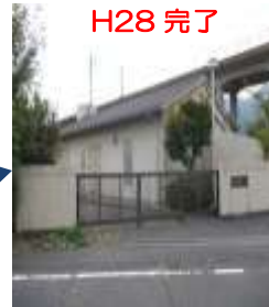
南小松中継ポンプ場 H28 完了
