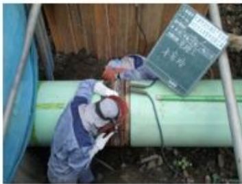
【ポリエチレン被覆鋼管布設工事状況】
