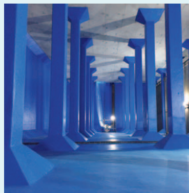
配水池の内部
