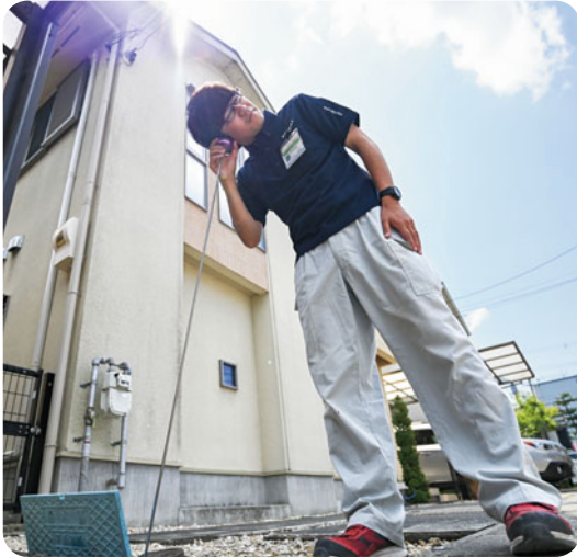
宅内の水道メーターなどに音聴棒をあて、漏水音の有無を調査します。
