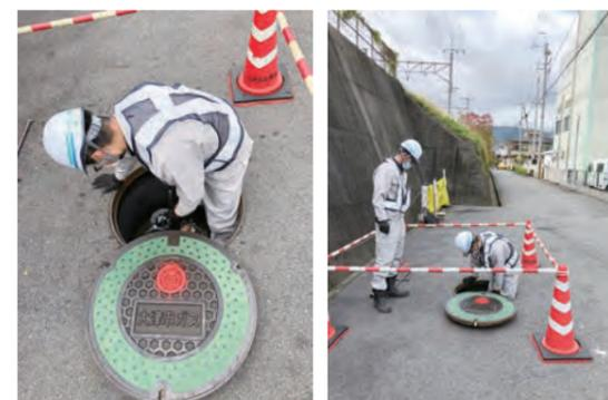
企業局では、安全にお客さま宅へガスをお届けするため、法律に基づき、重要なガス管を年1回、その他のガス管を4年で全線一巡するように調査しています。写真は、ガス検知器を用いてガス管を結ぶバルブからガスが漏れていないか調査している様子です。
