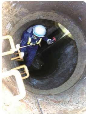
マンホール内点検の様子
