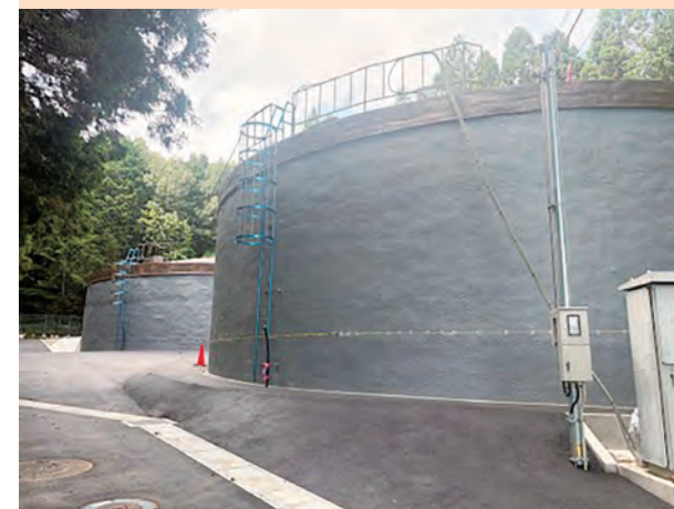
耐震補強工事中の膳所平尾配水池
