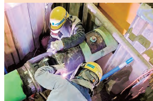
ポリエチレン被覆鋼管工事の様子
