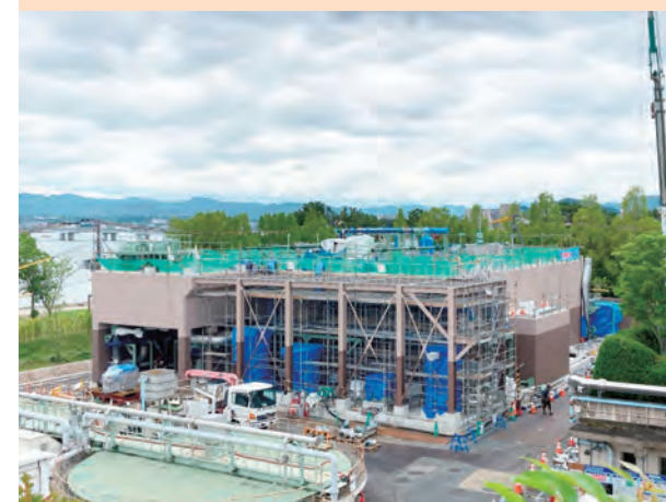
建設中の新1系水処理施設(令和8年6月時点)
