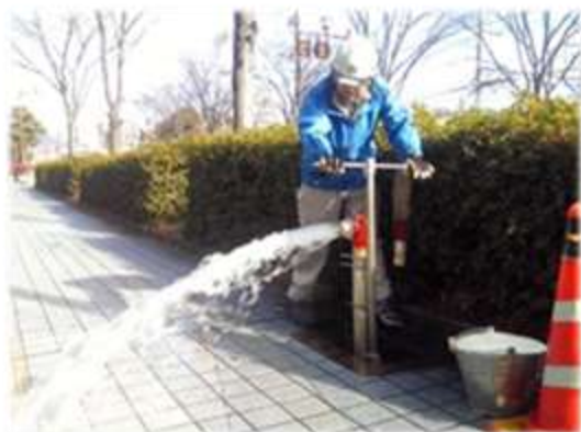
【水道管の洗浄作業（昼間作業）】
