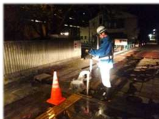
【水道管の洗浄作業（夜間作業）】
