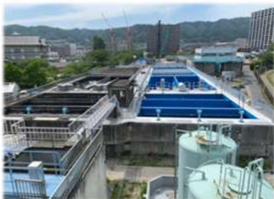
【耐震補強及び設備更新工事中の柳が崎浄水場】
