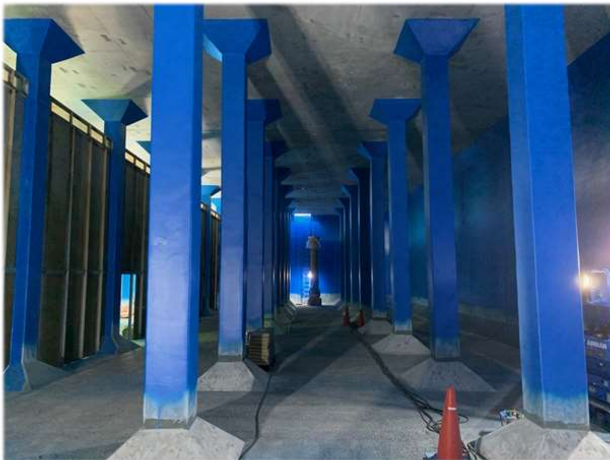
【耐震補強工事中の山上低区配水池】
