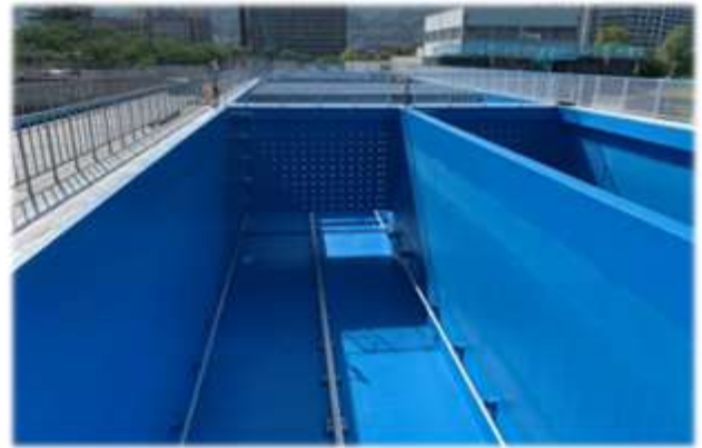
【耐震補強施工後の柳が崎浄水場沈澱池】
