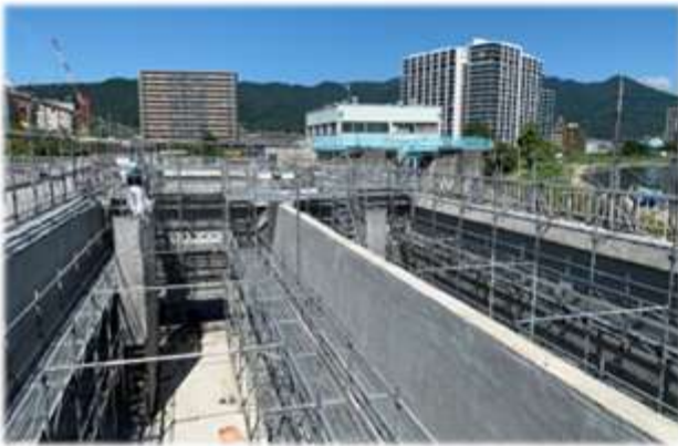
【耐震補強施工中の柳が崎浄水場沈澱池】
