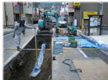
【配水支管における耐震管の布設状況】 （ダクティル鑄鉄管 GX 形 φ200mm）
