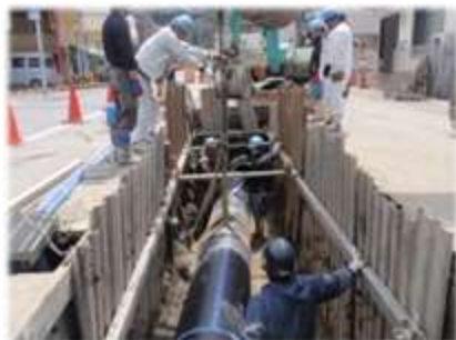
【基幹管路における耐震管の布設状況】 （ダクティル鑄鉄管 NS 形 φ600mm）
