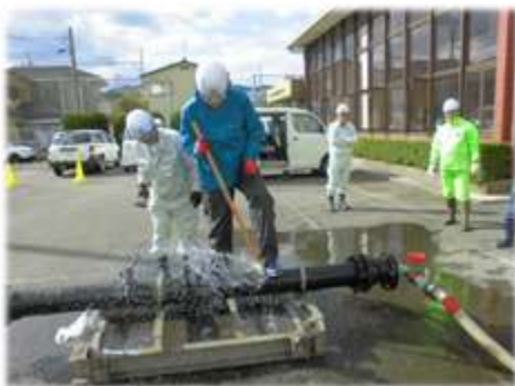
【漏水箇所修繕研修】
