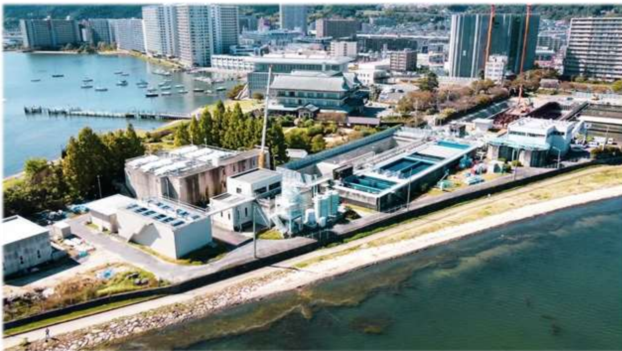
【更新改良中の柳が崎浄水場】
