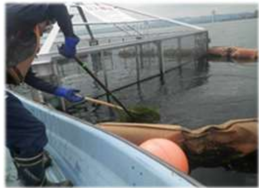
【取水口に繁茂した水草の除去作業状況 (柳が崎浄水場取水口)】
