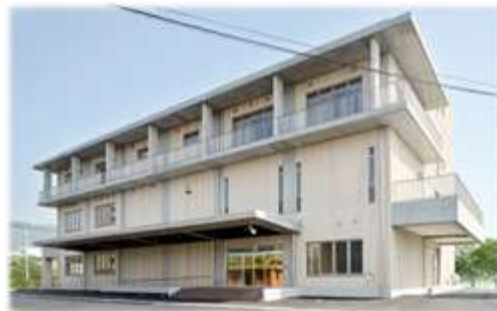
【浄水管理センター】
