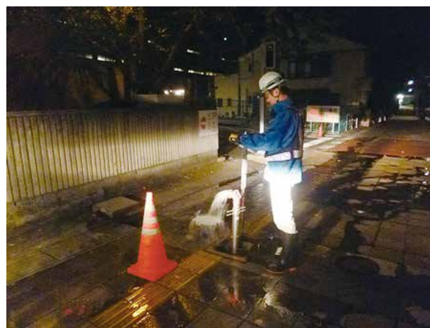
水道管の洗浄作業（夜間作業）
