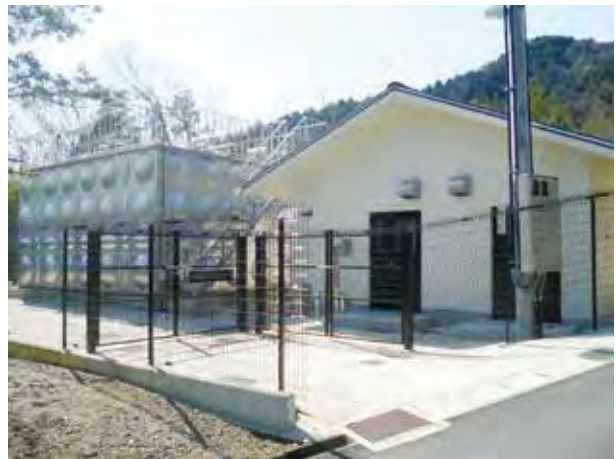
南小松配水池及び小松の森加压施設
