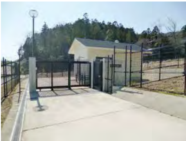
南小松加压施設
