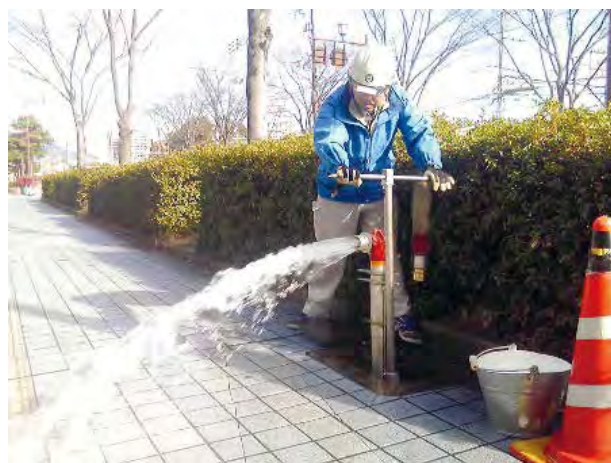
水道管の洗浄作業（昼間作業）
