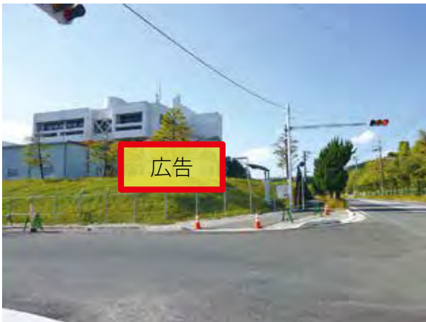
水道用地における広告看板の設置
