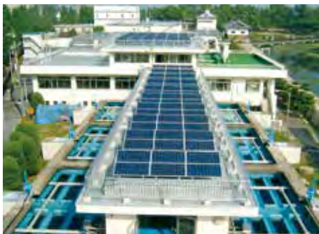
太陽光発電設備（膳所浄水場）
