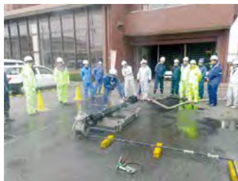
漏水箇所修繕研修
