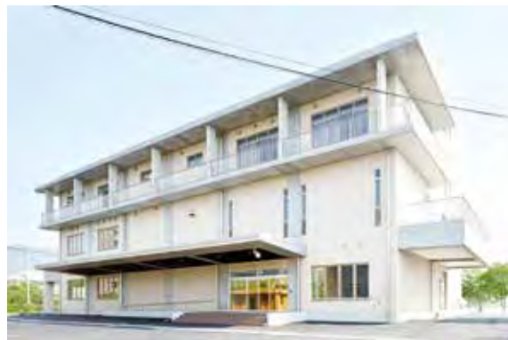
浄水管理センター
