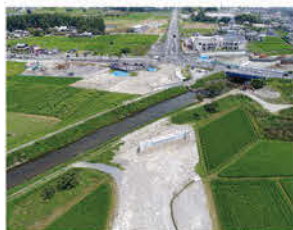
市道幹1009号線橋梁下部工工事
