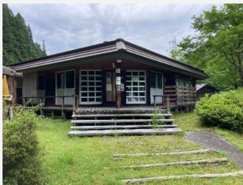
改修前の既存施設 管理棟
