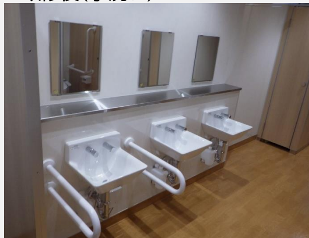
▶改修後(手洗い)
