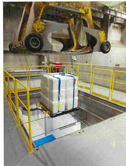
プラットホームから 投入口（2階）への搬送状況
