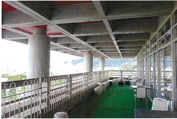
大津市庁舎本館 最上階展望室
