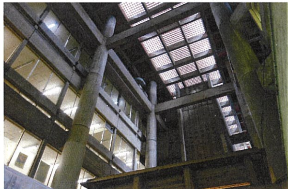
大津市庁舎本館 吹き抜け空間
