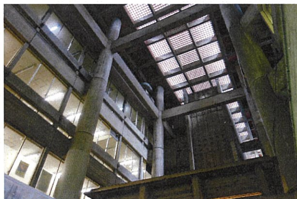
大津市庁舎本館 吹き抜け空間
