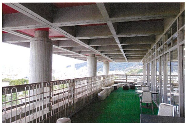
大津市庁舎本館 最上階展望室
