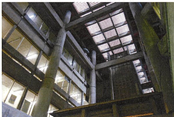
大津市庁舎本館 吹き抜け空間
