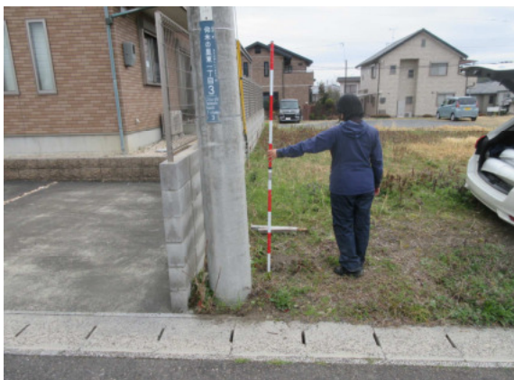
D12-53 (遠景) コンクリート杭
