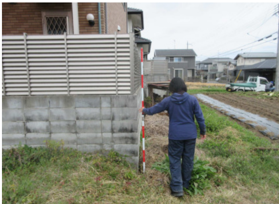
D12-122 (遠景) コンクリート杭
