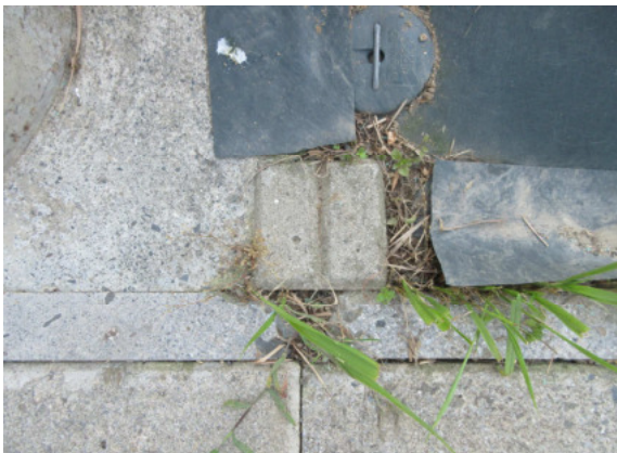
D 2 5 - 1 1 0 (近景) コンクリート杭
