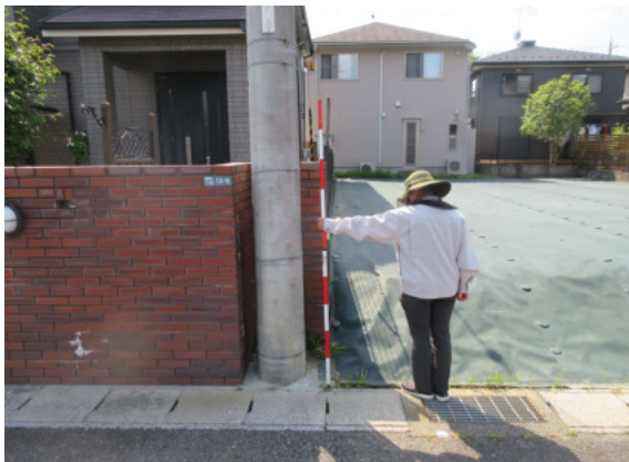
D 2 5 - 1 1 0 (遠景) コンクリート杭
