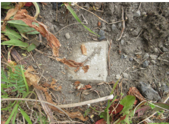
D12-53 (近景) コンクリート杭
