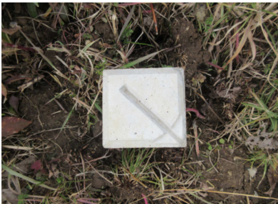
D12-117 (近景) コンクリート杭
