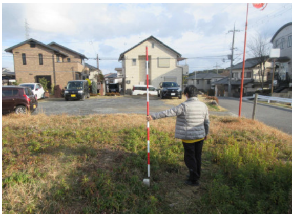
D12-117 (遠景) コンクリート杭
