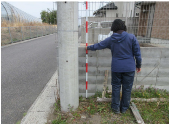
D12-54 (遠景) コンクリート杭
