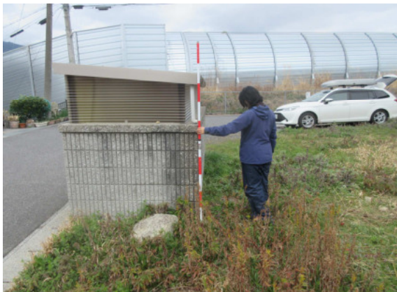
D12-118 (遠景) コンクリート杭
