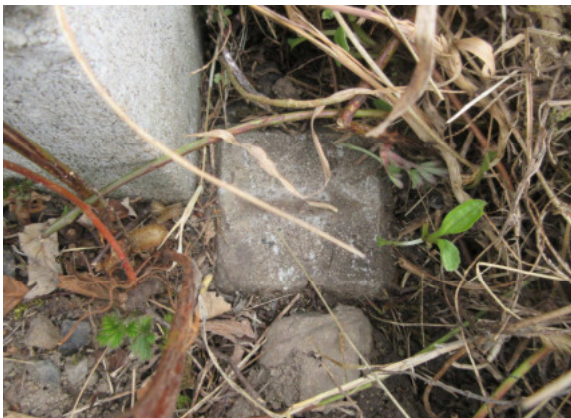
D12-122 (近景) コンクリート杭
