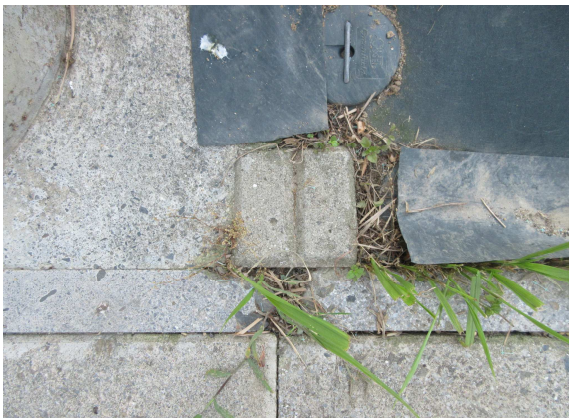
D 2 5 - 1 1 0 (近景) コンクリート杭
