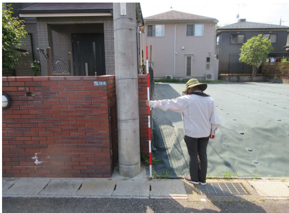
D 2 5 - 1 1 0 (遠景) コンクリート杭
