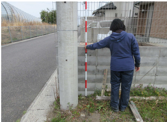
D12-54 (遠景) コンクリート杭
