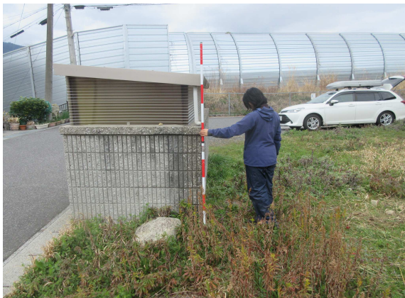
D12-118 (遠景) コンクリート杭
