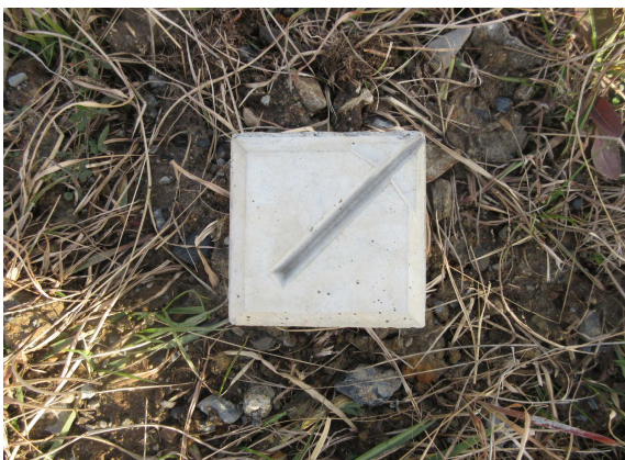
D12-123 (近景) コンクリート杭
