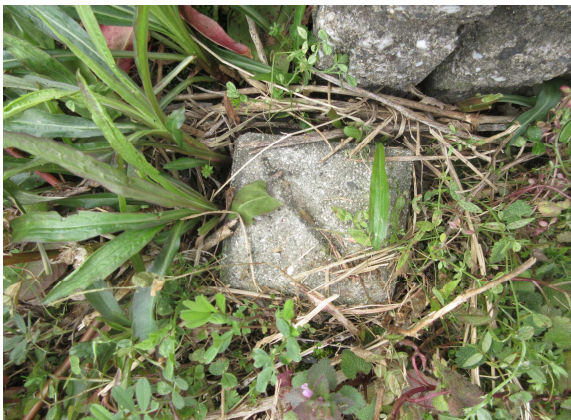
D12-118 (近景) コンクリート杭
