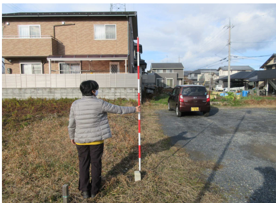
D12-123 (遠景) コンクリート杭
