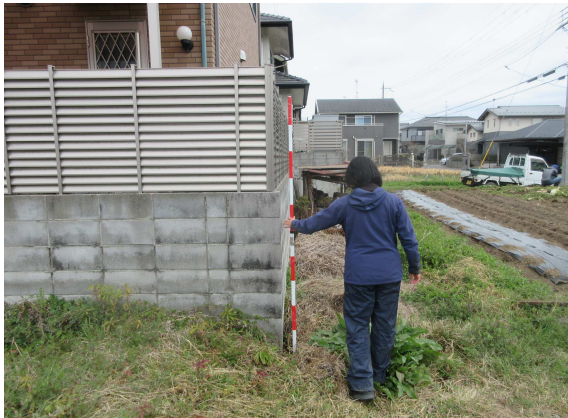
D12-122 (遠景) コンクリート杭
