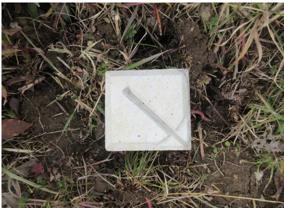
D12-117 (近景) コンクリート杭
