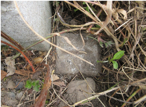
D12-122 (近景) コンクリート杭
