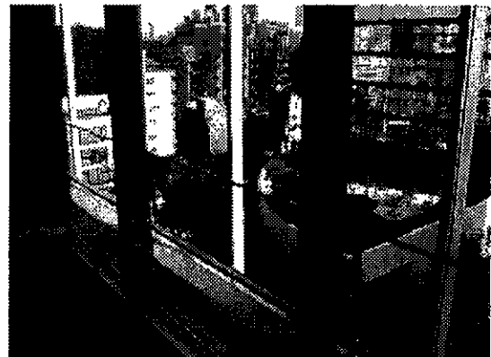
こんなところもアイデア。窓の外側に人が通れる作業足場がデザインを疎外せずに設けられている。窓を拭く清掃などのメンテが容易にできる。
