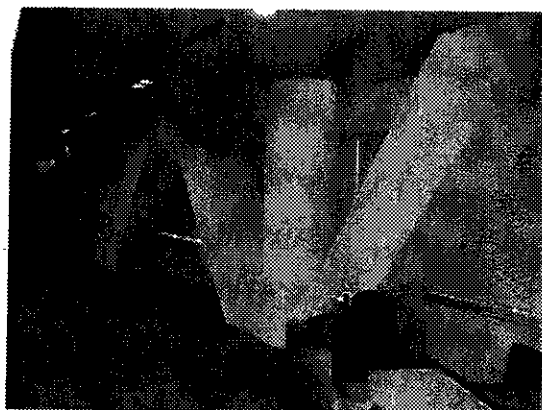
災害対策本部室のある階には特に耐震性能を高めるため筋交いが施されている。
