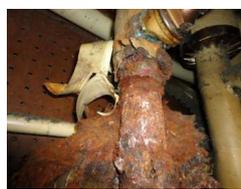
給水管外面に著しい腐食が見られる。
