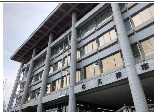
窓部ルーバーを改修した状態
