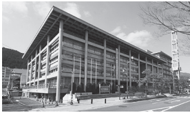
耐震性が不足している市役所本館
