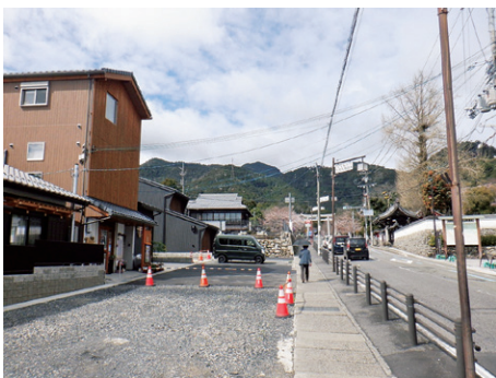
拡幅工事の様子
