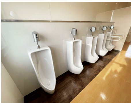
改修が進む学校トイレ
