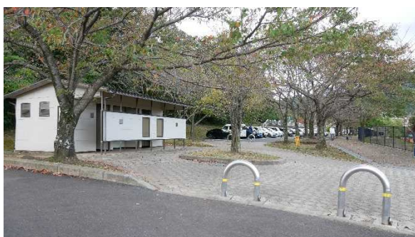
トイレ・駐車場
