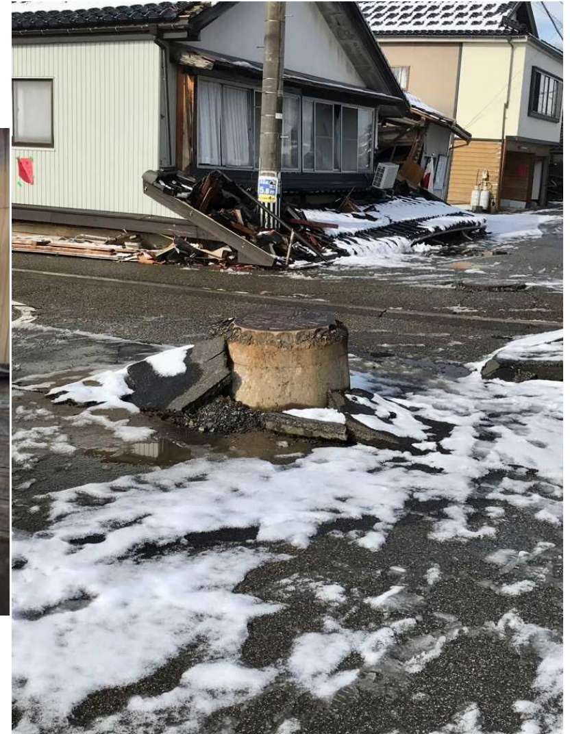
沿道一体の倒壊・液状化によるマンホールの浮き
