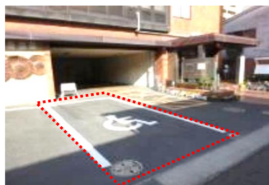
身障者用駐車場の設置
