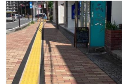
輝度比を確保した点字シートの設置例
