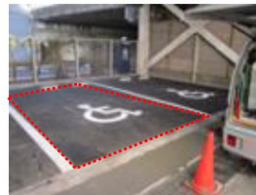
身障者用駐車場の設置
