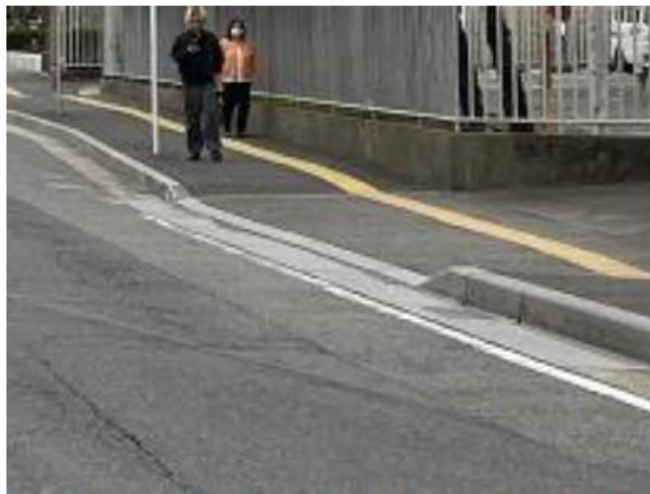
マウントアップの歩道の改修
