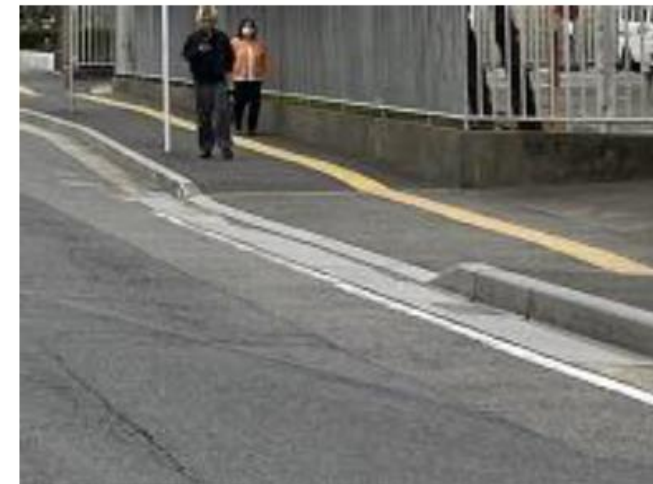
マウントアップの歩道の改修例
