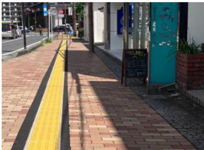
輝度比を確保した点字シートの設置
