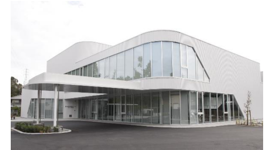
富士見市民温水プール
