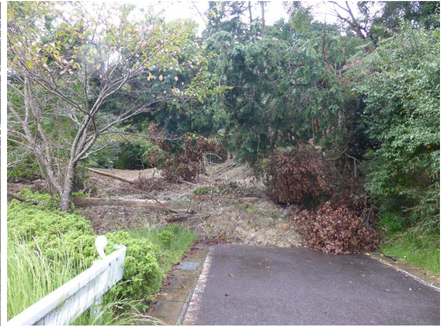
土石流発生後の現地
