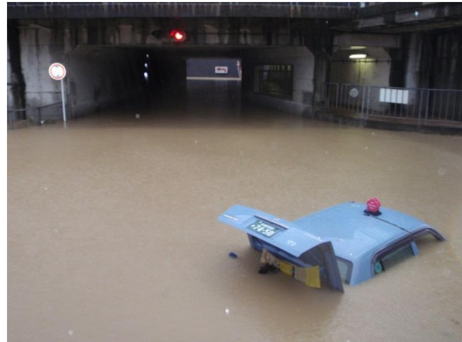
横木二丁目 アンダーパスの浸水
