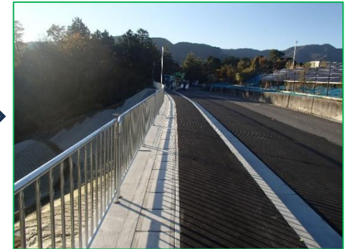
復旧状況(令和3年12月完工)
