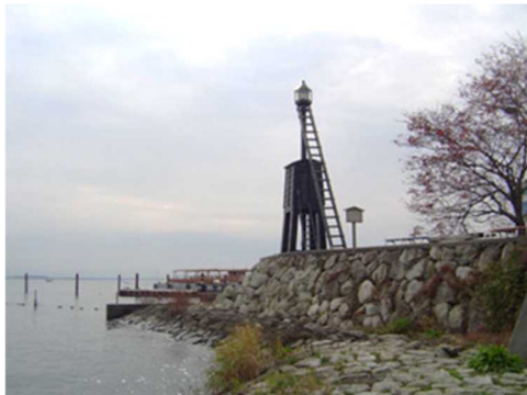
出島（でけじま）の灯台（湖岸通路）
