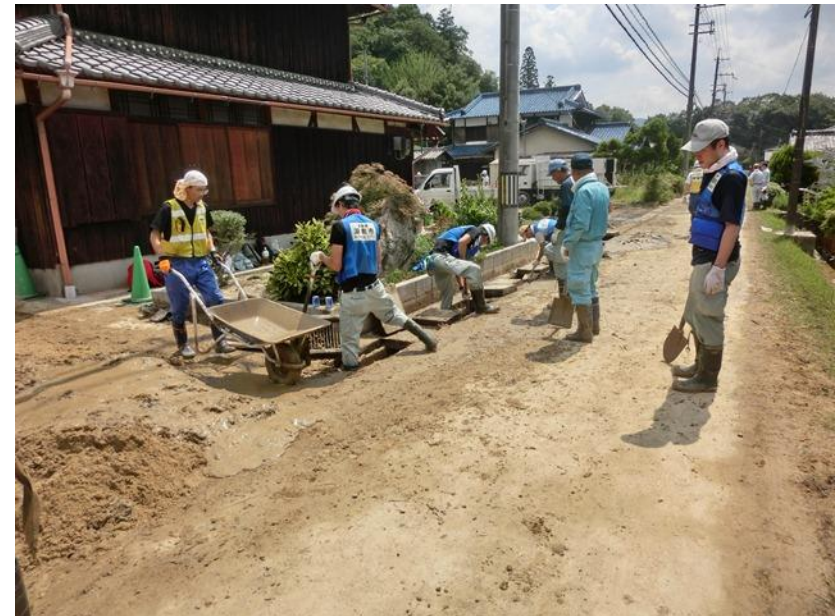
～ 集落内の土砂撤去作業 ～
