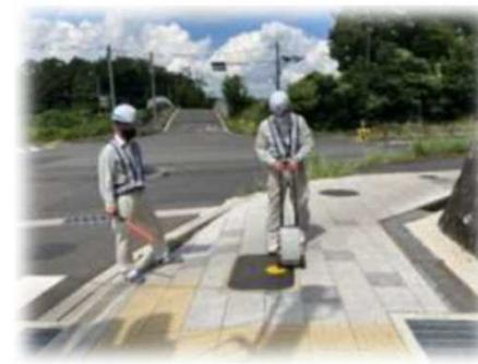
3. ガス導管漏えい検査
