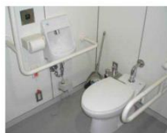
K 多機能トイレ オストメイト対応の多目的トイレには、地域開放利用に配慮しベビーシートやベビーチェアを設置している。また、各棟各階に設置している。
