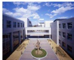
A 通り廊下 雨天時に濡れることなく移動ができる様に各棟を通り廊下で繋いでいる。
