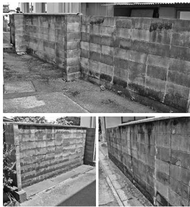
市内に多く存在するブロック塀
