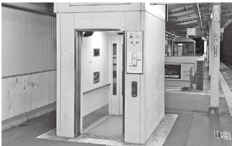
JR和邇駅に設置されたエレベーター
