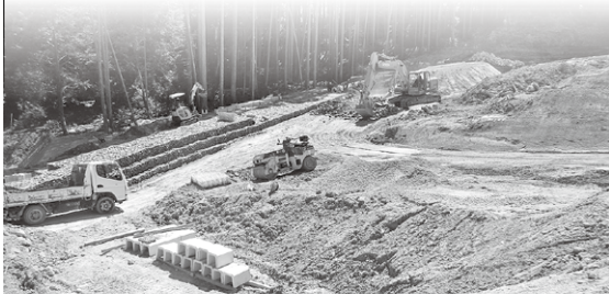
市道幹2028号線改良工事の様子
