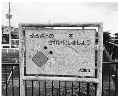
老朽化による劣化が目立つ河川愛護看板
